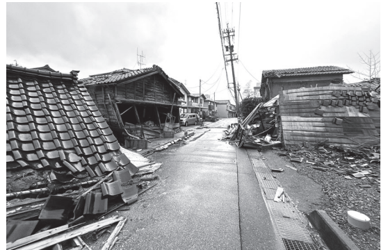
① 工房周囲の被災状況（左から2件目が工房）
