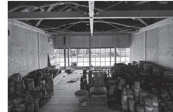
⑤ 復旧完了した工房（内観）
