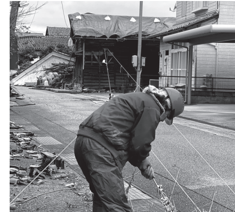
③ 建て起こし状況（ワイヤーで引っ張る）
