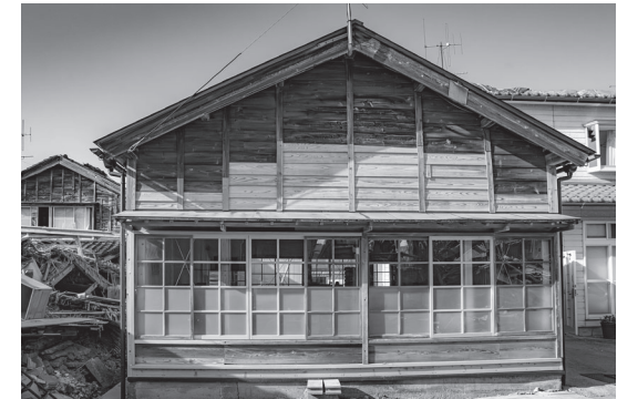
④ 復旧完了した工房（外観）
