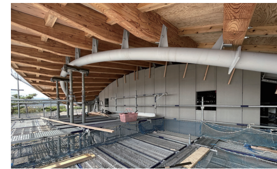
②庇先端鉄骨梁の製作状況(曲げ加工した三つの材の接続)
